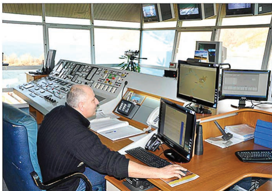
Slika 93. Kontrolni toranj Hidroelektrane Đerdap 1
